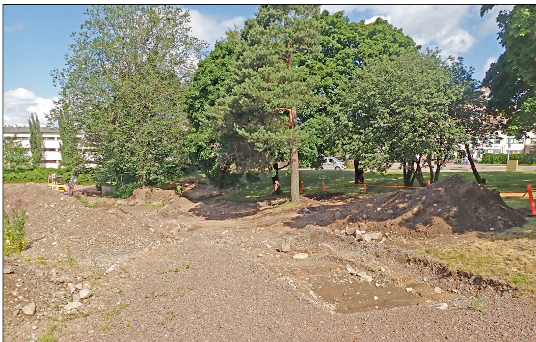
Valvonnassa kaivettu alue kokonaan avattuna. Kuvattu kaakkoisreunalta luoteeseen.
