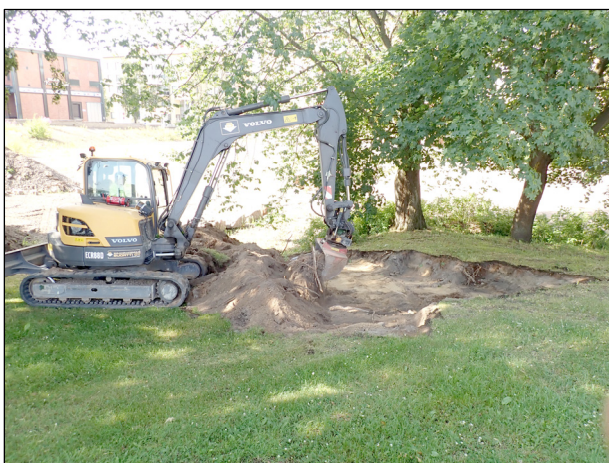
Kuva 4. Maata avataan alueen luoteispäässä. Kuvattu lounaaseen.
