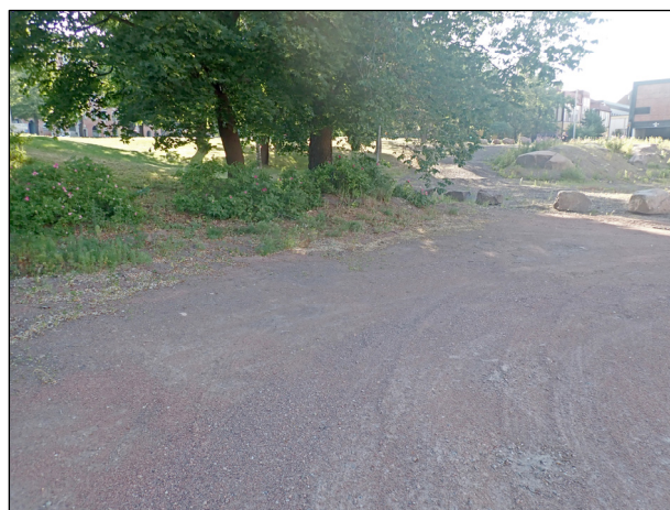
Kuva 3. Erillisen koeojan kohta ennen kaivua, itään kuvattuna.
